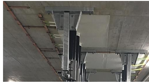
Abbildung 21: Erdung Kabeltragsystem Decke
