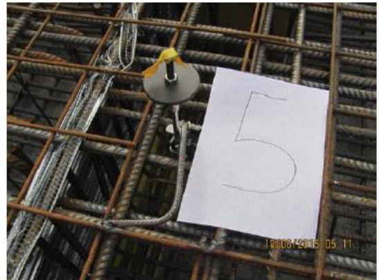
Abbildung 14: Anschlusspunkt HF-Netz
