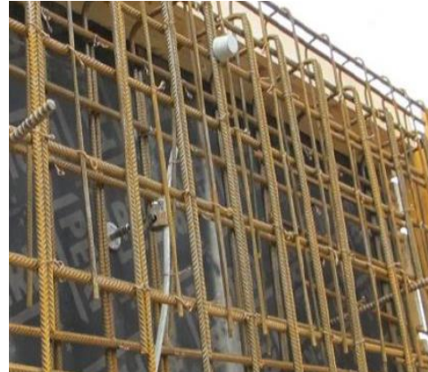
Abbildung 10: Fundamenterder, Anschlussgarnitur
