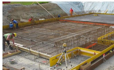
Abbildung 12: Bodenplatte mit Erdseil
