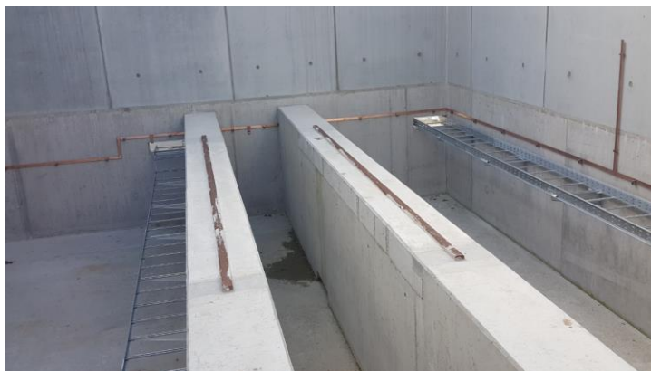
Abbildung 41: Erdung Transformatorwanne
