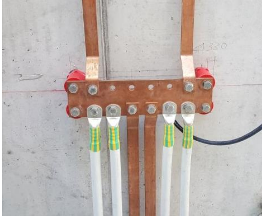
Abbildung 62: Erdungsschiene
