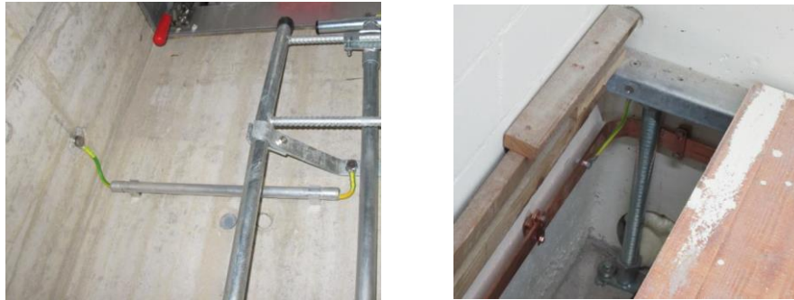
Abbildung 27: Erdung Metallteile
