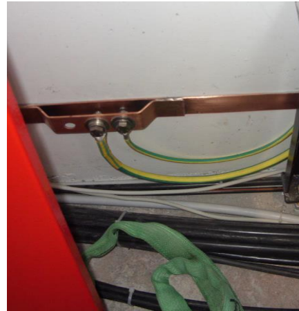
Abbildung 63: Anschlusslasche Kupferband
