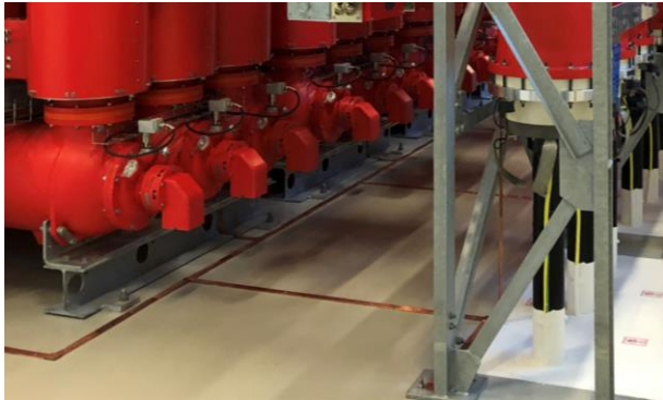
Abbildung 17: Anschluss GIS Erdung
