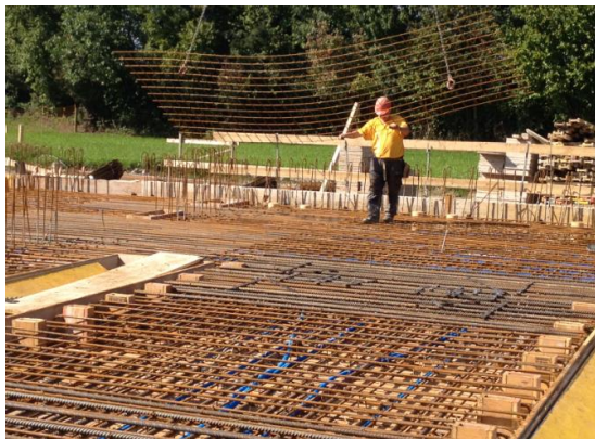
Abbildung 13: Einbau HF-Netz
