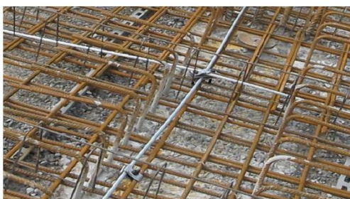
Abbildung 11: Verbindung Erdseil / Armierung
