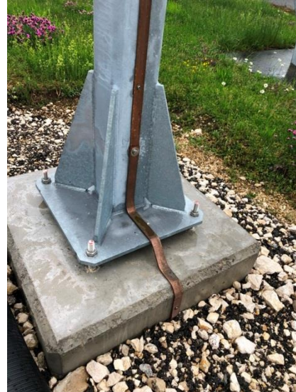
Abbildung 74: Verlegung Kupferband auf Stahl
