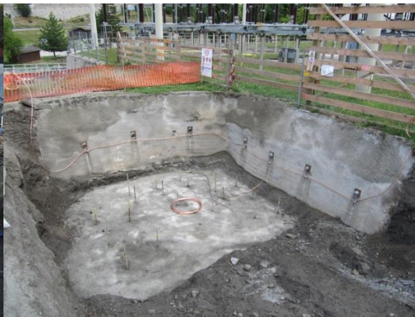
Abbildung 9: Tiefenerder kombiniert mit Hangsicherungsanker
