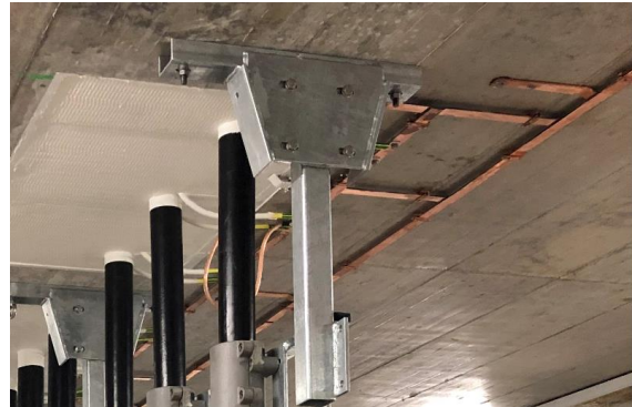
Abbildung 18: Anschluss an Erdungsleiter in Kabelkeller
